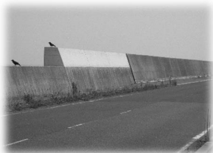
1. 白い嵩上げ部分 (高さ 1m)
