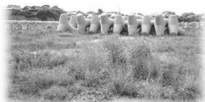
3. 向坂に積まれた消波ブロック
