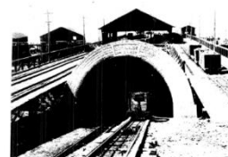
長生炭鉱と同規模の坑口 本山炭鉱第1坑 (昭和15年)
